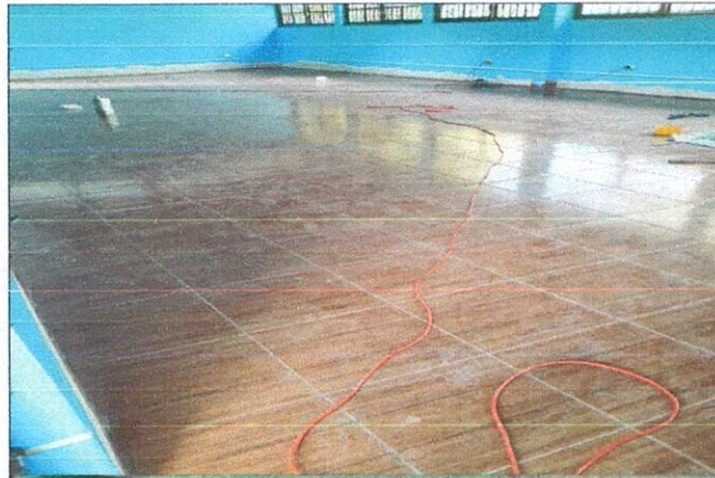
Foto 4: Finalización de mejoramiento del piso
