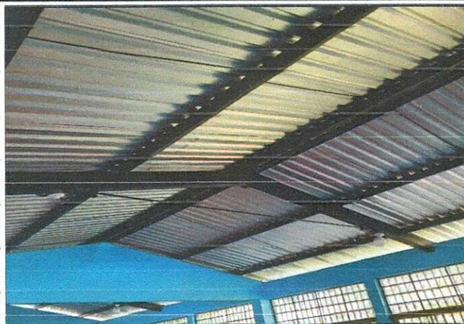
Foto1: finalización de la cubierta de Lámina
