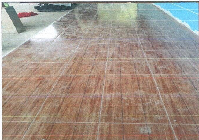
Foto 2: Finalización de mejoramiento del piso
